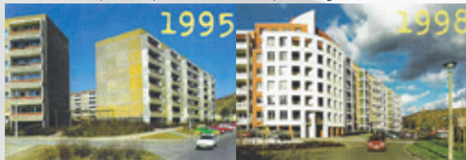
Grumsiner Straße (Kompetenzzentrum Großsiedlung e. V.)
