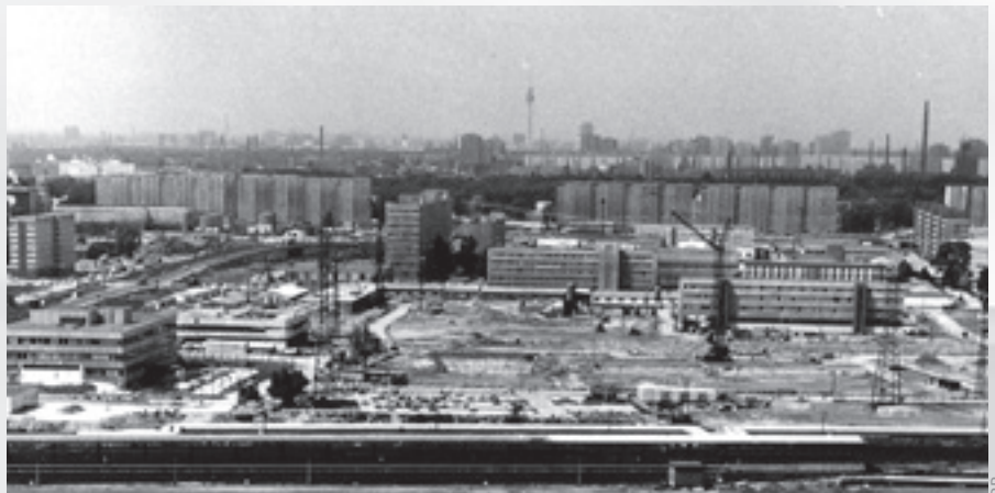
Industriebauten entstehen an der Allee der Kosmonauten westlich des S-Bahnhofes Springpfuhl
